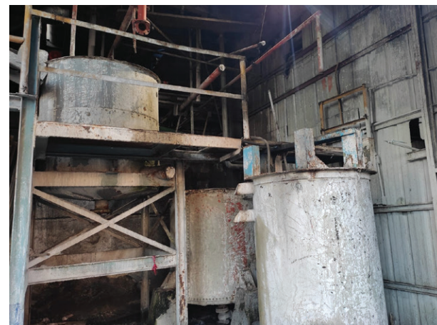
Vista del Sistema de Preparo de Lechada de Cal antiguo.
