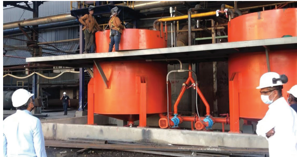
Nuevo Sistema de Preparo de Lechada de Cal.
