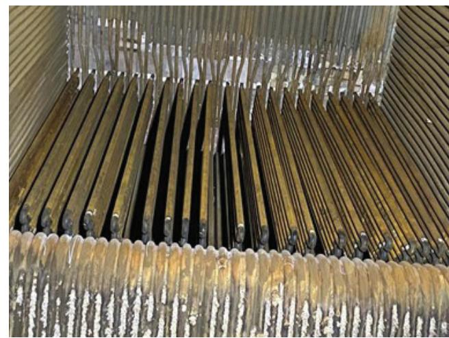
Muestra del cambio de tubería en la Caldera 10.
