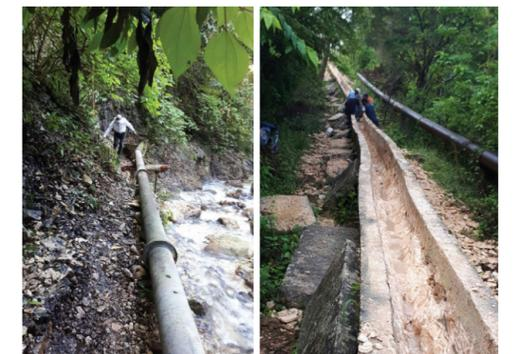
Red de conducción en tubería
