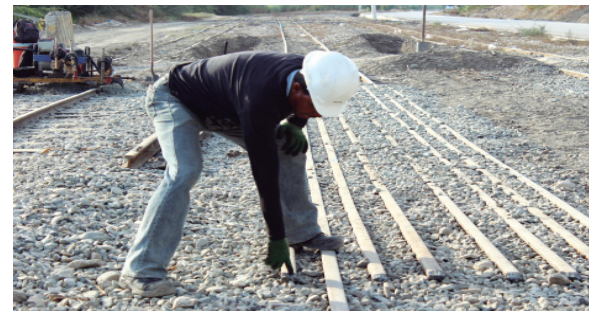
Cruce Batey 6-Batey 7.- La readecuación y mejora de este cruce fue otro trabajo importante que se realizó.
