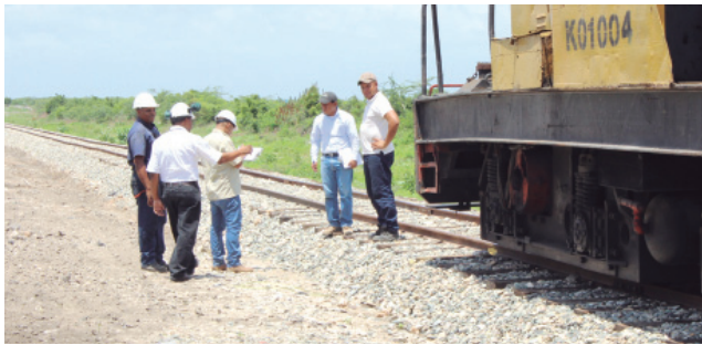
Calidad.- El equipo de técnicos y supervisores del CAC se asegura de que los trabajos tengan éxito haciendo su control de calidad con pruebas en las vías.
