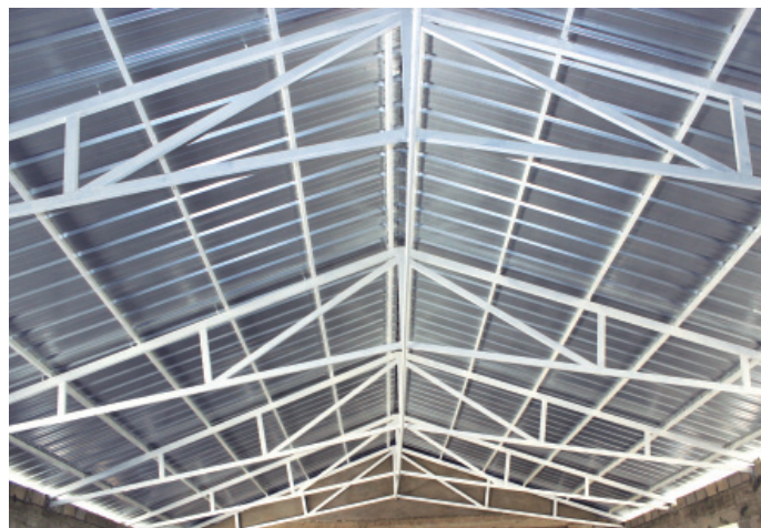
La instalación del techo de la Parroquia San Martín de Porres fue posible gracias a la contribución del CAC.
